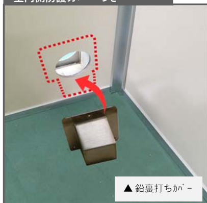
配線用貫通口（1箇所） 室内側防護カバーつき
